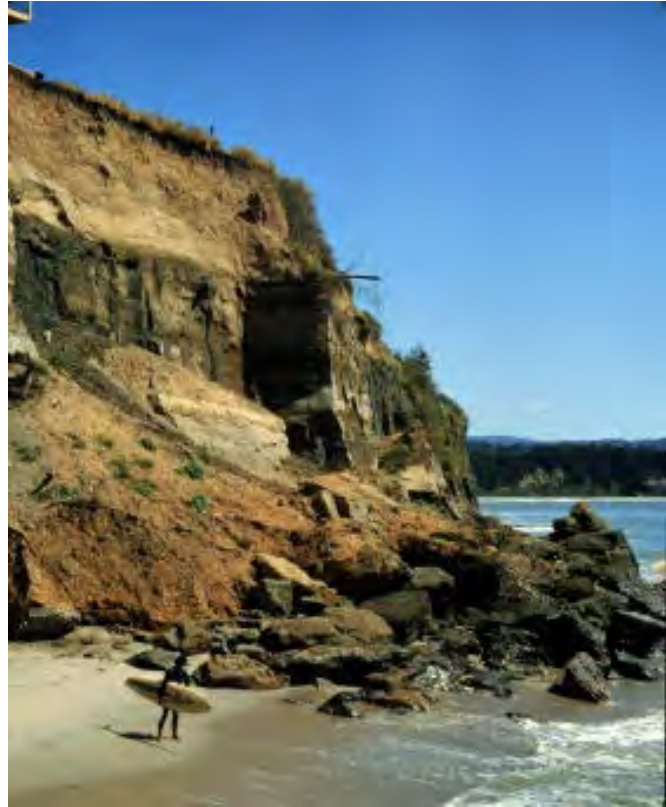
Figure 11 - Episodic coastal bluff failure in Capitola
