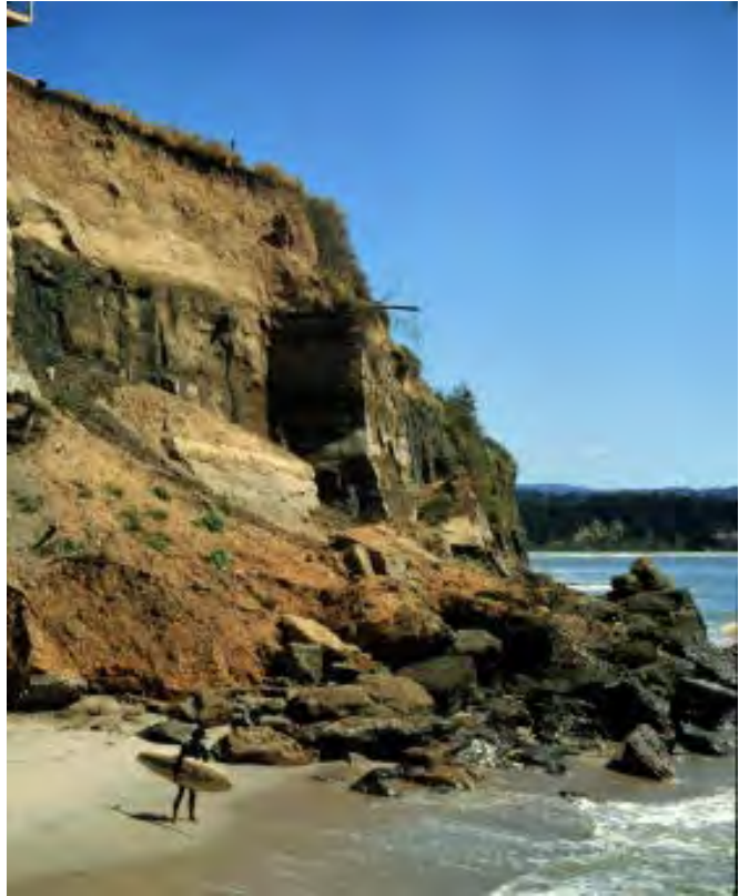
Figure 11 - Episodic coastal bluff failure in Capitola
